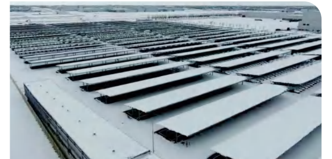
沈阳市华晨宝马项目
