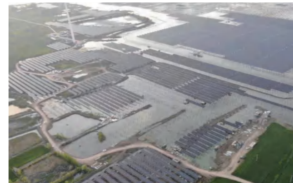
项目地: 中国·江苏泗洪 容量: 108MW 解决方案: 固定支架+平单轴跟踪系统
