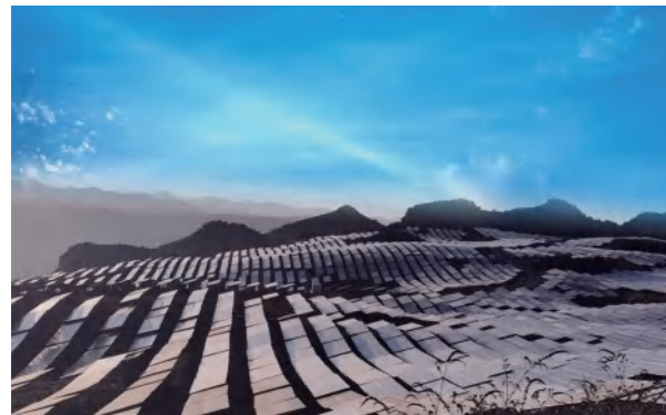
项目地: 中国·贵州 容量: 340MW 解决方案: 固定支架
