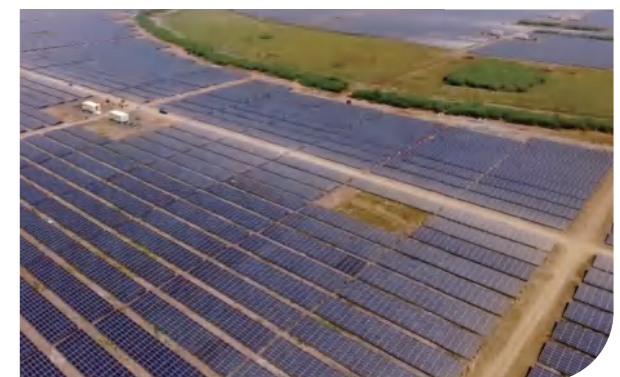
项目地: 印度 容量: 648MW 解决方案: 固定支架
